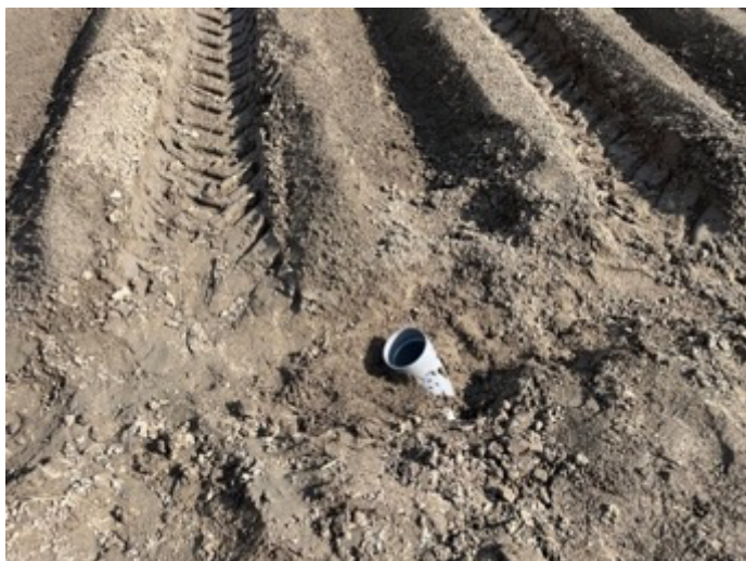
Figuur 7 In de greppel aan het eind van de ruggen begint de buis naar de sloot. Door een bochtje omhoog wordt voorkomen dat er te veel water afspoelt.
