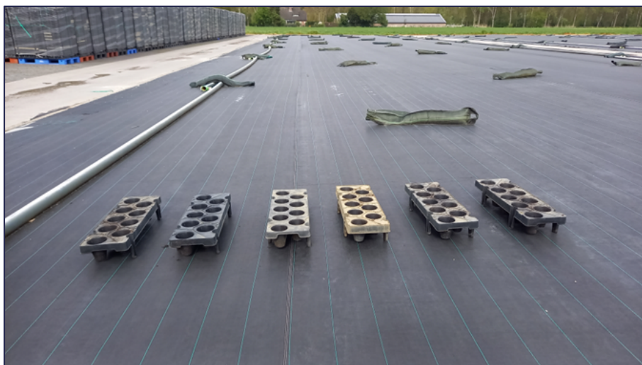
Figuur 1 Regulier trayveld. Trays staan op worteldoek met daaronder waterdicht zeil. De afdekking loopt bol af naar de rijpaden aan beide kanten. Daaronder ligt drainage wat het water van de verhardingen afvoert naar een opvangbekken. De rijpaden zijn verhard.
