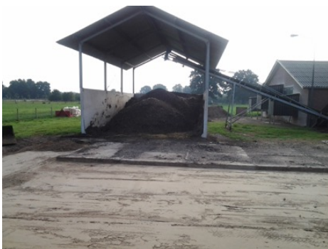
Foto: Overkapping bij de opslag van vaste mest
