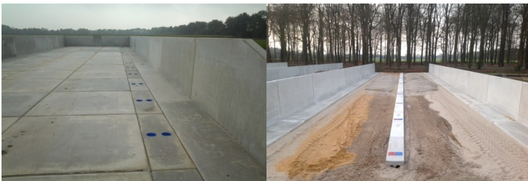
Foto: Aanleg van de zogenaamde duogoot in een voeropslag in twee uitvoeringen
