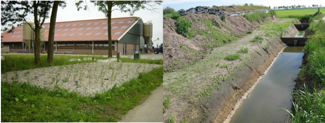
Foto: Helofytenfilter (links) en cascadesloot (rechts) voor het zuiveren van erfafspoelwater op een veehouderijbedrijf
