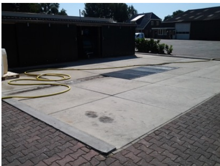
Foto: wasplaats met opvangvoorziening
