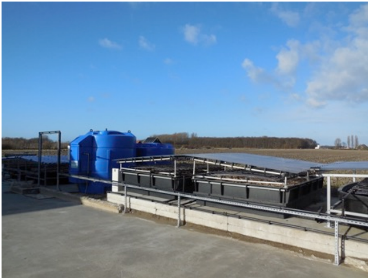
Foto: Phytobac waarin gewasbeschermingsmiddelen worden gebonden aan organische stof, waarna ze worden afgebroken door bacteriën en schimmels. Water verdampt door zon en wind.
