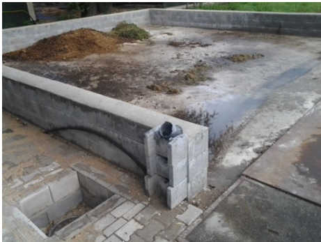
Foto: Aanleg opslag van vaste mest met opvangput
