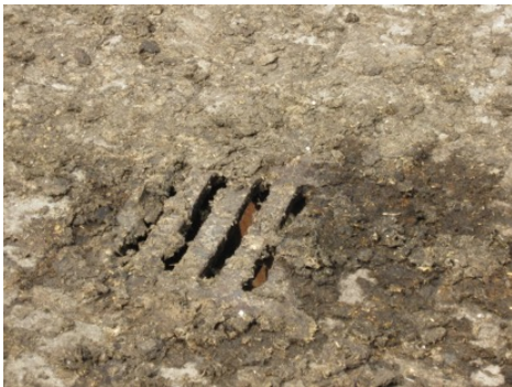
Foto: Straatkol in het koepad op het erf met een afvoer naar de mestkelder
