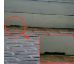
Foto 6: twee invliegopeningen zodat vleermuizen de ruimte achter gevelbetimmering kunnen gebruiken.
